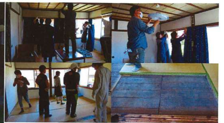
まずは部屋の中の備品を撤去します。畳をめくってみると、床板が古くなっていて、ぶかぶかのヤバイ状態です。
