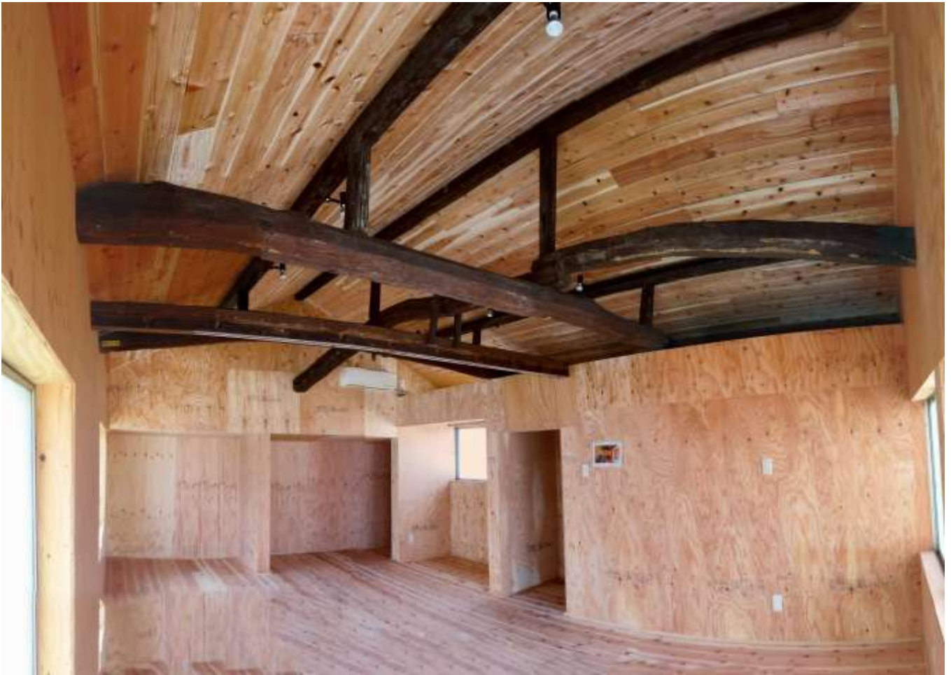
2階内装工事後
