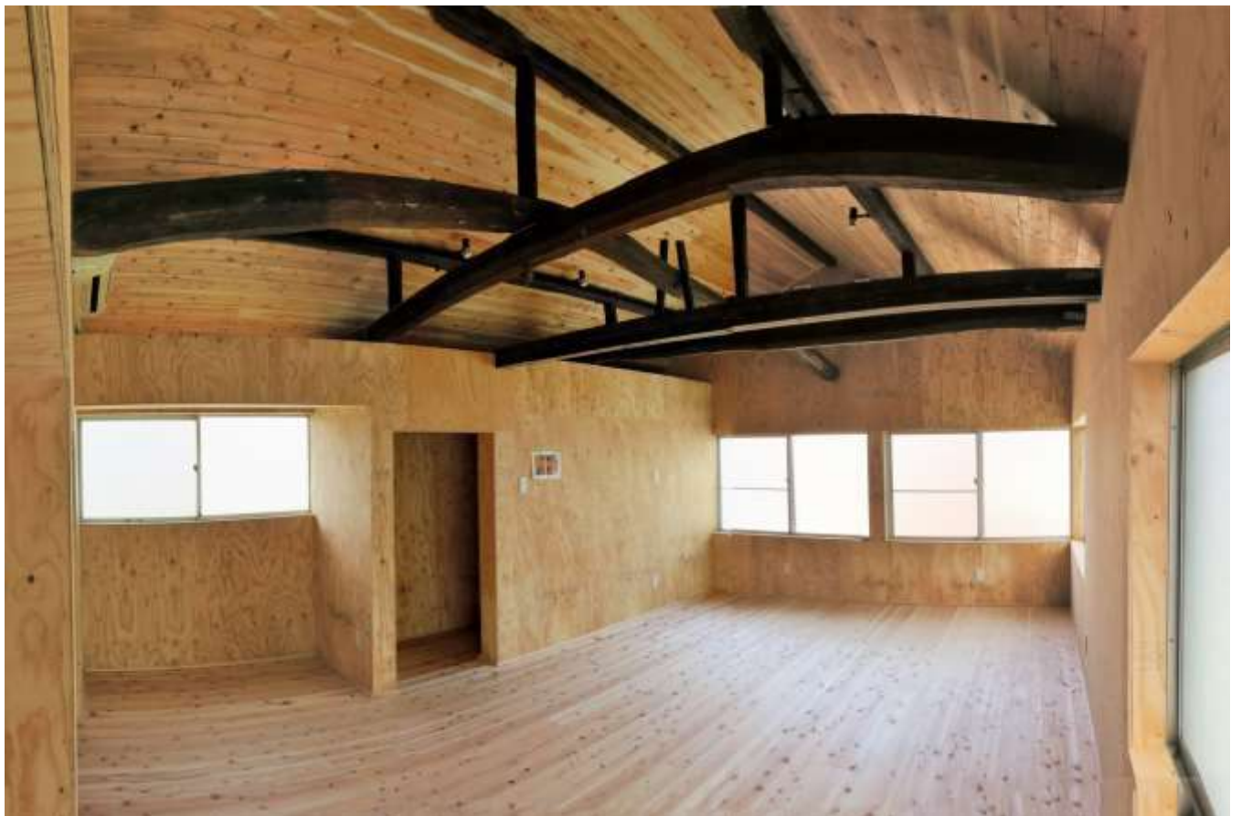
2階内装工事後
